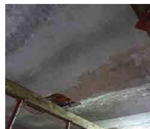
Ce qui fut fait, car une fois le reste de la dalle déposé, la chaudière démontée et la cuve à fioul extraite, une nouvelle dalle a été coulée en juin puis étanchéifiée, et enfin couverte d'enrobé mi-juillet. Parallèlement à cela et jusqu'à la fin de l'été, les entreprises en charge du chauffage ont travaillé au sous-sol afin d'installer une
